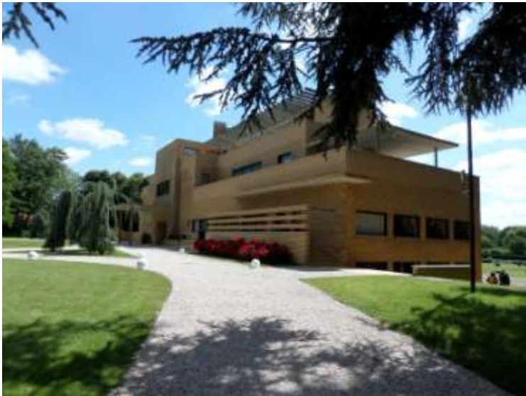
La villa vue de l'entrée historique
