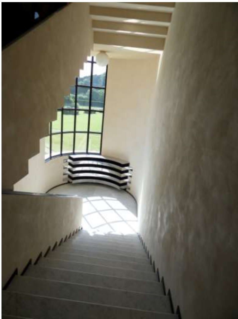
Un escalier, avec chauffage et baie vue sur le parc
