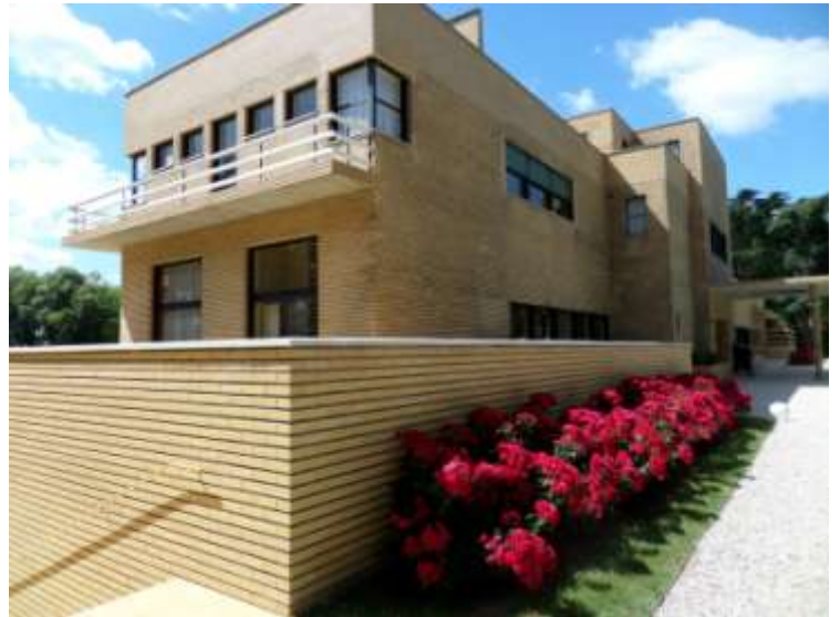
Vue de côté vers la descente du garage
