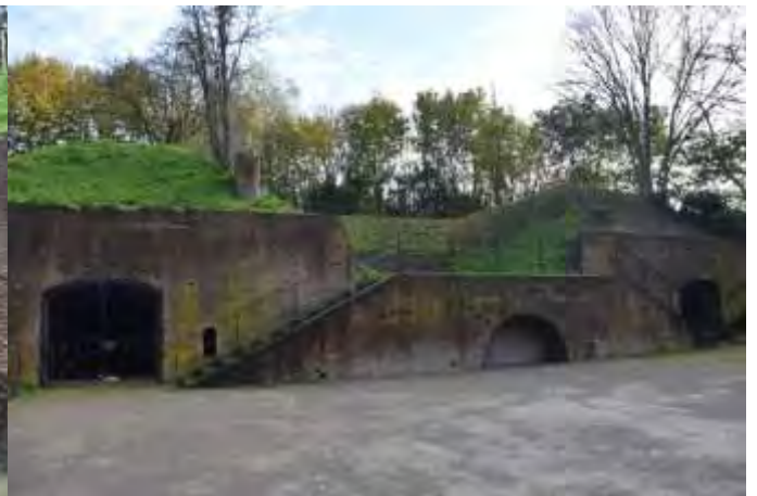
Les emplacements des canons, le couloir et les escaliers d'alimentation
