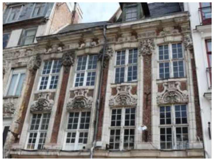
Façade rue Esquermoise
